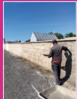
RECRÉPISSAGE DU MUR EXTÉRIEUR DU CIMETIÈRE
