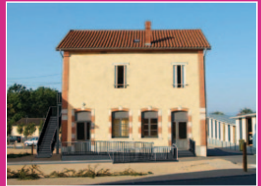
BÂTIMENT DE LA SALLE DES ASSOCIATIONS APRÈS TRAVAUX
